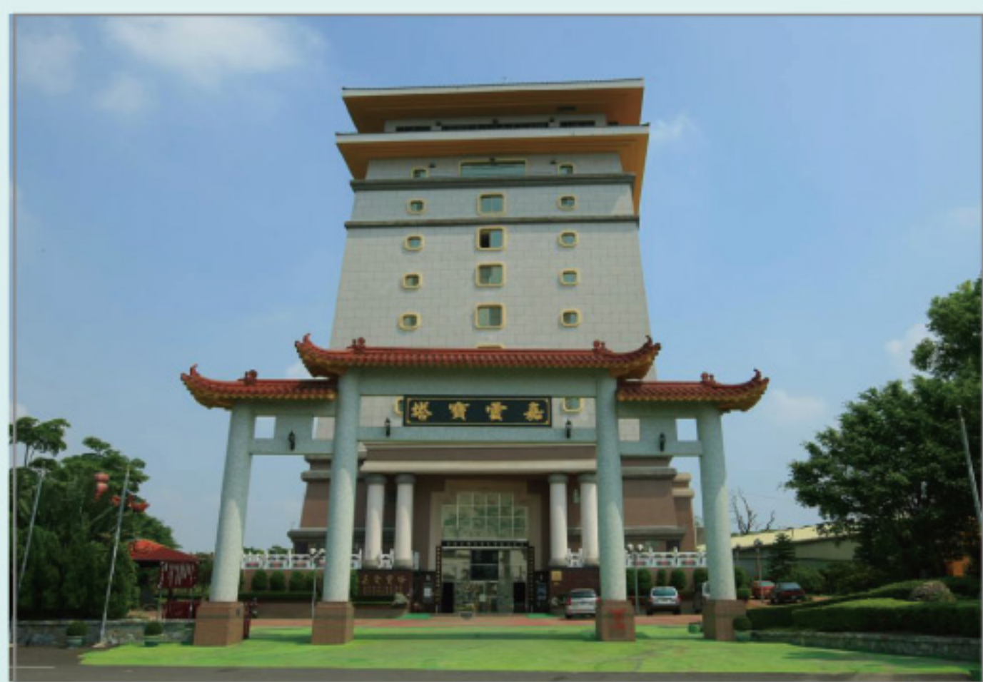
嘉雲寶塔：施工前
