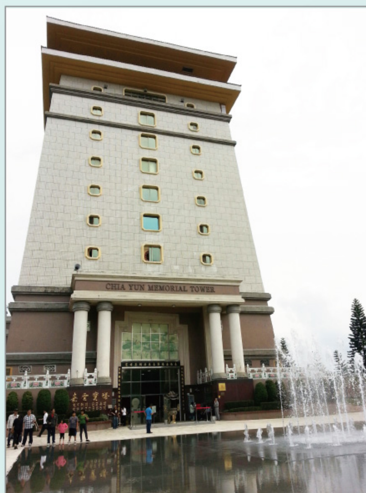
嘉雲寶塔施工後
